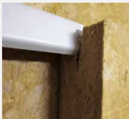
Zárez do izolácie na uchytenie do C kazety, hĺbka zárezu 40 - 100 mm.
