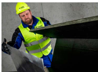
5. Jednoducho zložíme VZT potrubie.
