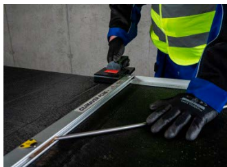
2. Pomocou náradia zhotovíme stupňovú drážku.
