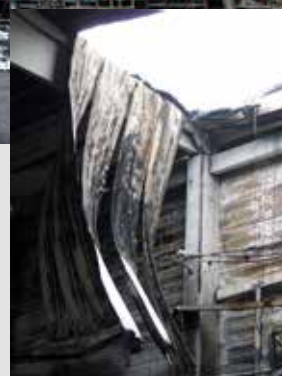
Obr. 2, 3: Priemyselná hala v areáli Havraň v okrese Most po ničivom požiari. Ľahká, požiarne odolná strecha musí zaistiť dostatočný čas na evakuáciu osôb. Chybný návrh je neprípustný.
