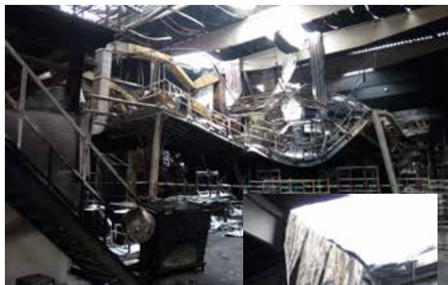
Obr. 2, 3: Priemyselná hala v areáli Havraň v okrese Most po ničivom požiari. Ľahká, požiarne odolná strecha musí zaistiť dostatočný čas na evakuáciu osôb. Chybný návrh je neprípustný.
