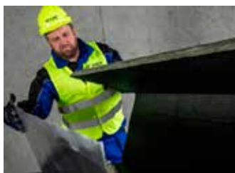
5. Jednoducho zložíme vzt potrubie.
