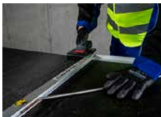
2. Pomocou náradia zhotovíme stupňovú drážku.
