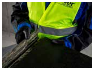
3. Odstránime vyrezaný kus sklenej vlny z drážky.
