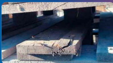
Zle upevnená doska a uvoľnený klinec
