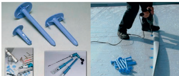
Příklad kotvení fóliové hydroizolace teleskopickými kotvami.
