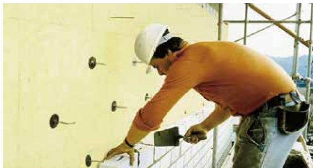
Obr. 3.B.6 Dosky ISOVER MULTIMAX 030 kotvené na trne
