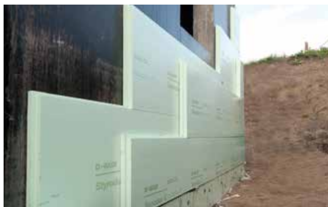
Obr. 6.D.1 Zateplenie suterénu izoláciou STYRODUR® 3000CS
