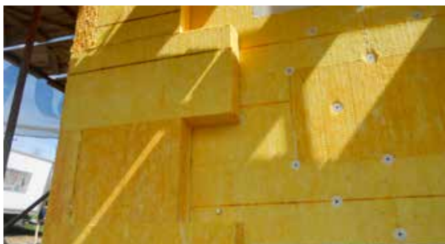
Obr. 6.A.2 Sklená vlna ISOVER Clima 034 aplikovaná na zateplenie ultranízkoenergetického domu
