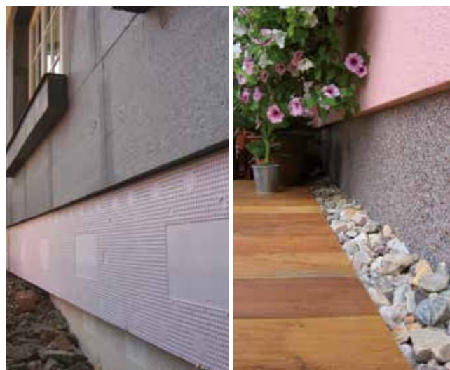
Obr.3.D.5 Dôsledne zateplený sokel budovy
