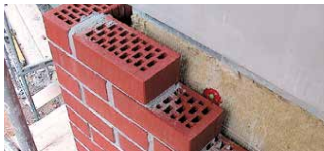
Obr. 4.C.1 Obrázok prevetrávanej fasády s murovanou predstenou
