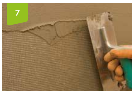
Obr. 5.A.1 Základný postup montáže ETICS
