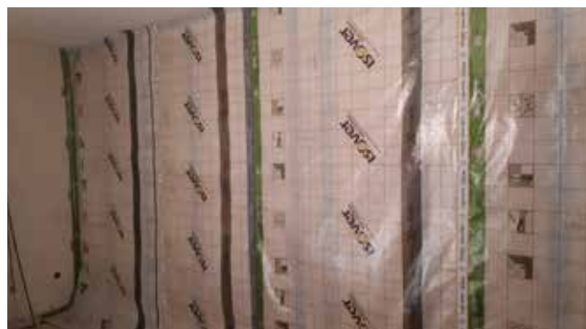
Obr. 3.A.5 V prípade vnútorného zateplenia minerálnou vlnou je nutné použiť parozábranu alebo lepšie riešenie, inteligentnú klímamembránu systému ISOVER VARIO®
