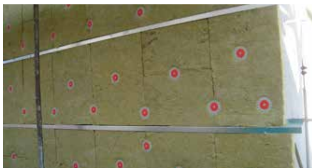
Obr. 3.B.5 Dosky ISOVER FASSIL vkladané do horizontálneho roštu a montážne prikotvené
