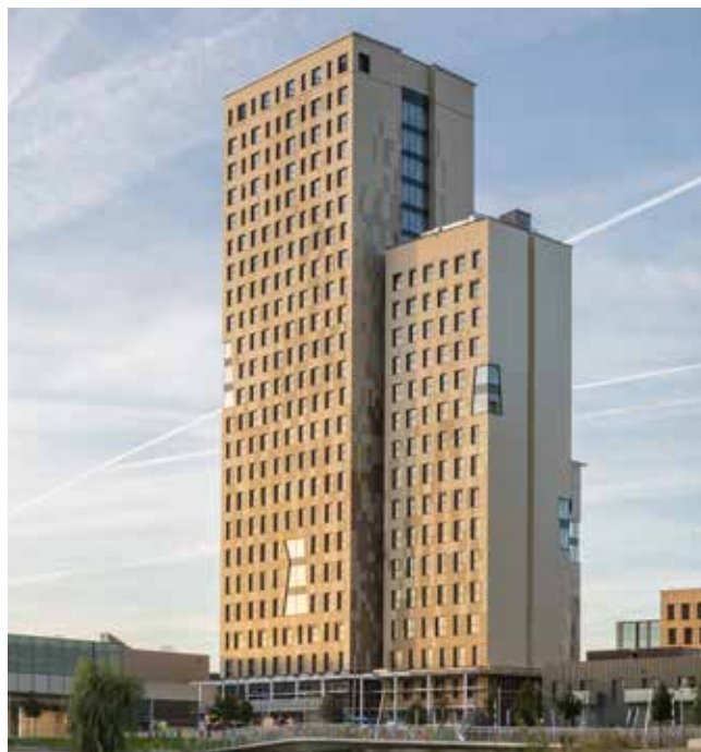
Obr.3.C.1 Výšková budova HOHO Wien zhotovená prevažne z dreva. Zdroj: Kerbler Holding GmbH
