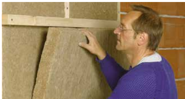
Obr. 3.B.4 Dosky ISOVER FASSIL vkladané do dreveného roštu
