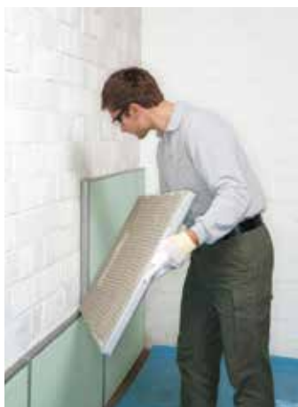
Obr. 3.A.4 V prípade vnútorného kontaktného zateplenia polystyrénom volíme extrudovaný polystyrén s difúzne nepriepustnou stierkou alebo vákuové panely zaliate v doske XPS
