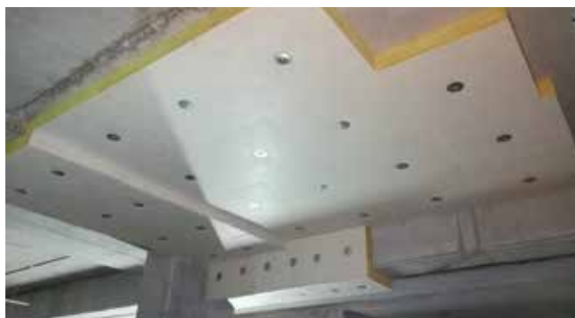
Obr. 6.A.3 Sklená vlna ISOVER STROP MAX 031 aplikovaná na zateplenie stropu garáží
