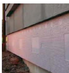
Obr. 2 - Príklad použitia výrobku ISOVER EPS SOKLOVÁ DOSKA 200
