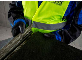
3. Odstránime vyrezaný kus sklenej vlny z drážky.
