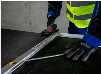
2. Pomocou náradia zhotovíme stupňovú drážku.
