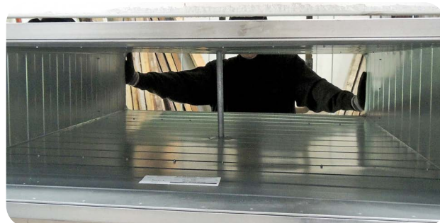
Obr. 60 Vyztužení segmentu potrubí uprostřed rozpětí.
