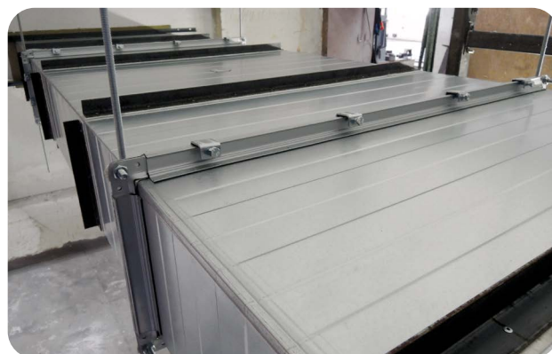
Obr. 61 Vnější vyztužení L-profilu.
