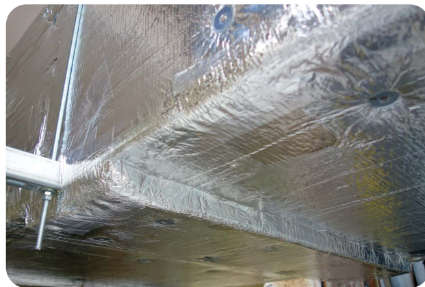
Obr. 27b Pohled na alternativní provedení izolace závěsného profilu.
