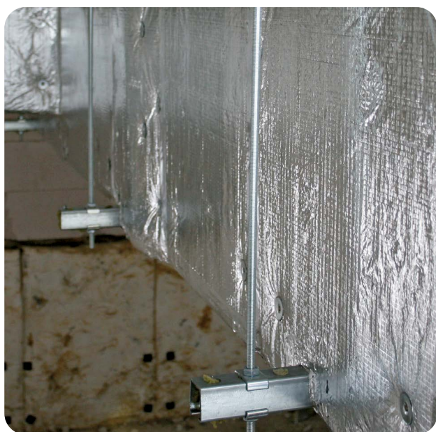
Obr. 21 Zavěšení potrubí závitovými tyčemi a nosnými profily. Na obrázku jsou závitové tyče umístěny vně izolace (část nosného profilu vyčnívajícího z izolace se v tomto případě neizoluje, pouze se vyplňuje odřezky na tloušťku izolace).
