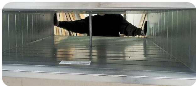
Obr. 37 Vyztužení segmentu svislého potrubí uprostřed rozpětí.
