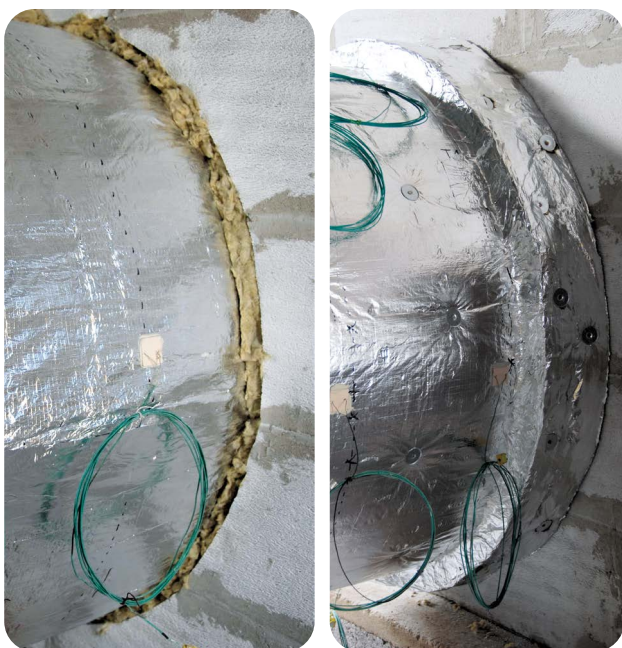
Obr. 35 Požární ucpávka řešená izolačním límcem – před provedením izolačního límce z druhé vrstvy lamelové rohože se nejdříve vycpe meziprostor mezi izolovaným potrubím a požárně dělicí konstrukcí.
