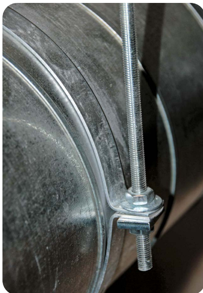
Obr. 31 Detail dvoudílné objímky pro zavěšení kruhového potrubí.
