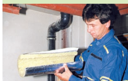
Tepelně izolační pouzdro před instalací.
