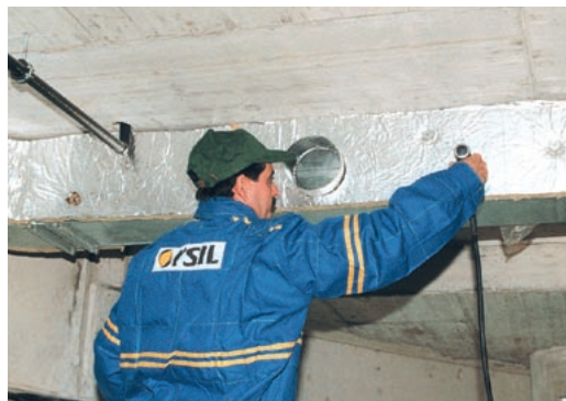
Připevnění desek Orstech k potrubí.
