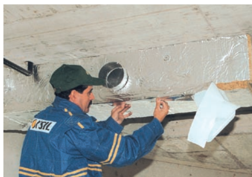
Přelepení spojů a nepolepených hran.
