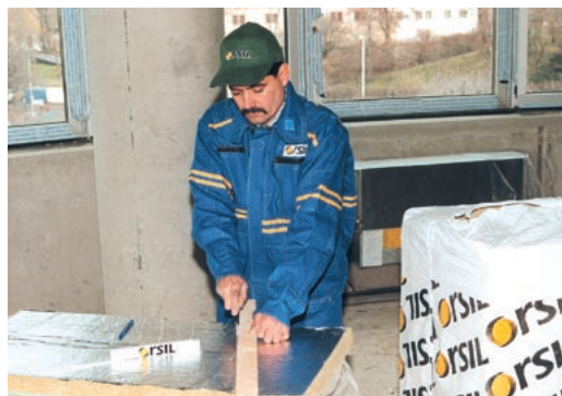
Úprava rozměrů desek Orstech.
