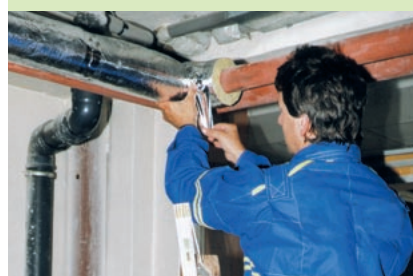
Uzavření povrchu izolantu dosáhneme přelepením spojů.
