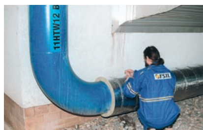
Izolace potrubí lamelovou rohoží Orstech LSP H.
