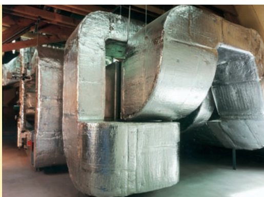
Přelepení spojů a nepolepených hran.
