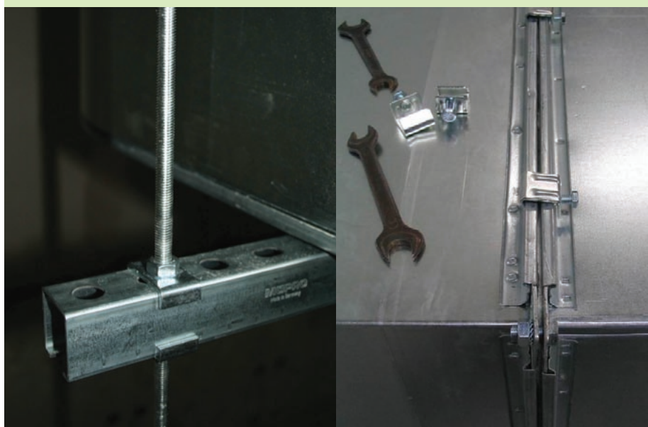
Příruby s těsnící izolační šňůrou zajištěny stahovacími svorkami se šrouby.
