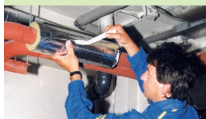
Odstranění ochranné vrstvy samolepícího přesahu hliníkového polepu.
