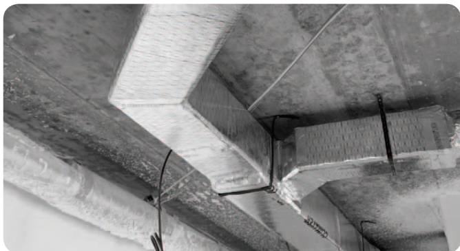
Inštalácia potrubia do bytových jednotiek bez nutnosti použitia tlmiča hluku.
