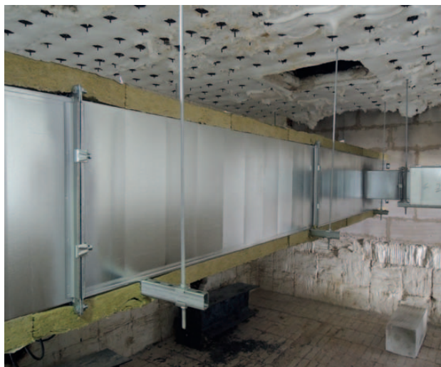
Obr. 29 Standardní jednovrstvé kladení izolace v místě přírub
