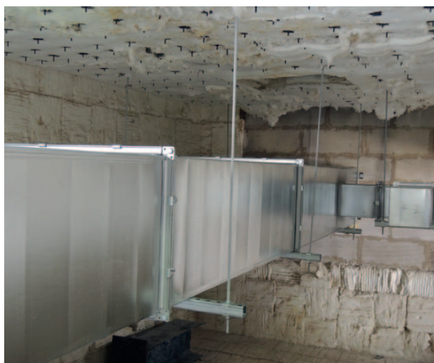
Obr. 28 Detail kotvení druhé vrstvy izolace, není-li zachováno krytí izolace nad přírubou nebo instalačním profilem min. tloušťky 20 mm
