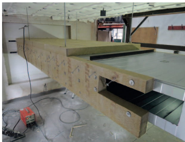
Obr. 74 Horní deska se nekotví přivařovacími trny, pouze se kotví požárními vrtů Fire Screw k boční desce
