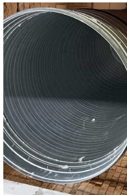
Obr. 33 Pohled na spiro potrubí spojovaného vsuvkami, oba konce vsuvky jsou opatřeny intumescentním akrylátovým tmelem nebo keramickou páskou
