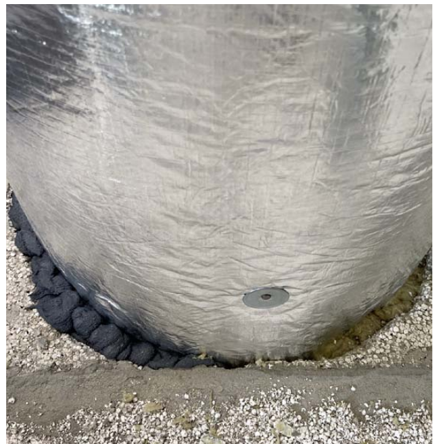
Obr. 37 Prostup bezpečnostním blokem (3i-isolet)
