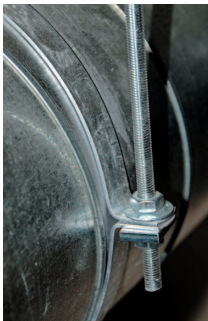
Obr. 32 Detail dvoudílné objímky pro zavěšení kruhového potrubí
