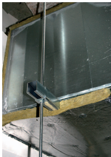
Obr. 20 Izolování instalačního profilu výšky 40 mm izolací tloušťky 40 mm
