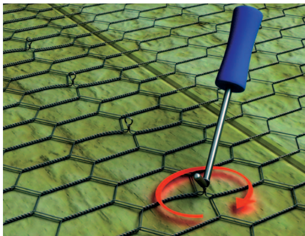
Obr. 61 Spojení rohoží překroucením přiléhajících okrajů pletiva do sebe po vzdálenosti cca 100 mm
