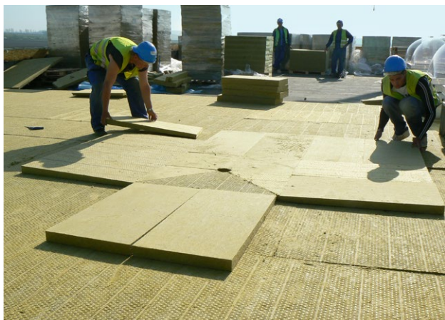
Spádování ploché střechy pomocí klínů z minerální vlny
