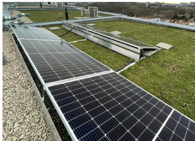
Fotovoltaické panely umístěné na zelené střeše, foto: GREENTOP
