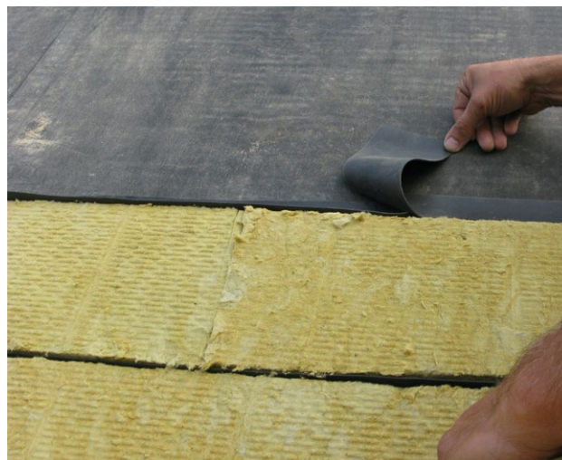
Drenážní zpomalovače, foto: ACRE
