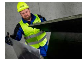
5. Jednoducho zložíme VZT potrubie.
