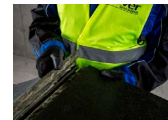
3. Odstránime vyrezaný kus sklenej vlny z drážky.
