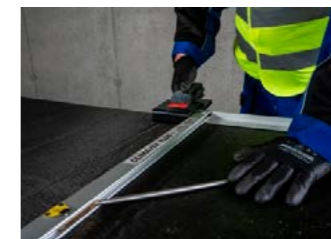
2. Pomocou náradia zhotovíme stupňovú drážku.
