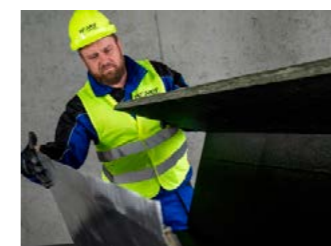
5. Jednoducho zložíme VZT potrubie.
