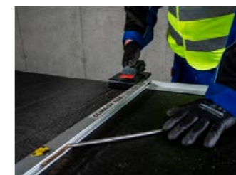
2. Pomocou náradia zhotovíme stupňovú drážku.
