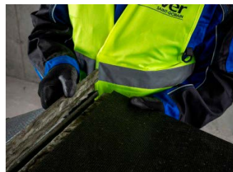
3. Odstránime vyrezaný kus sklenej vlny z drážky.
