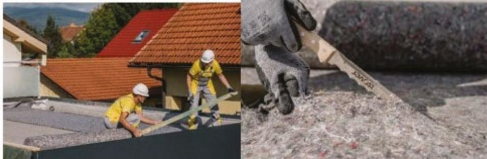
Geotextília plošnej hmotnosti 300 g/m<sup>2</sup> bude chrániť hydroizolačnú fóliu pred mechanickým poškodením. Pri realizácii intenzívnej vegetačnej strechy je potrebné použiť geotextíliou s vyššou plošnou hmotnosťou.
